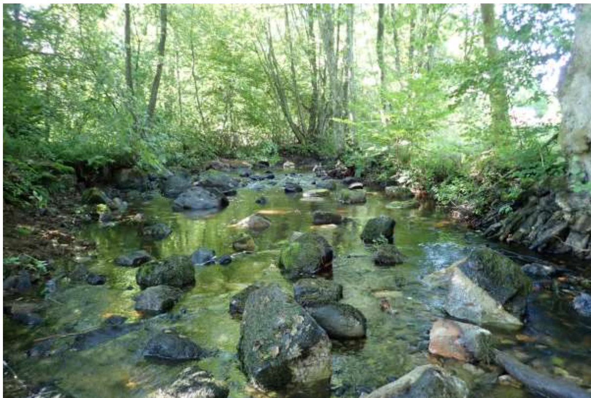
Bilden visar återställning av en tidigare rensad sträcka i Stensån ned väg 24 i Nordanå.
