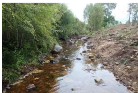
Före restaurering och efter restaurering åns kanter har fasats ned och grus och sten har tagits fram från åns kanter.
