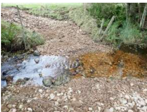
Plats 2. före restaurering. Plats 2 efter restaurering. Naturgrus har lagts ut på vattendragets kanter för att förhindra kotramp och jorderosion samt för att skapa ett lek område för öring.
