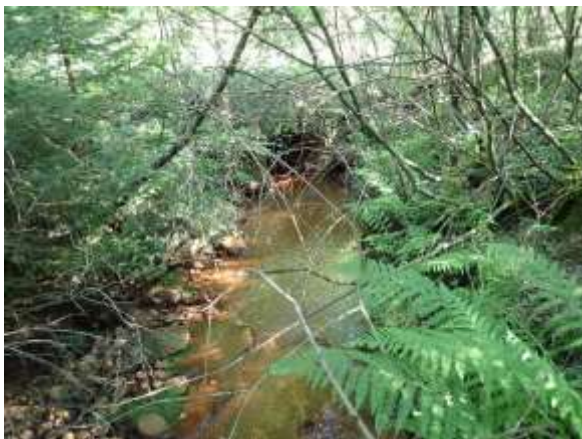
Uppströms grusväg (B101).
