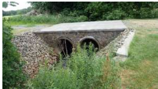
Lekområde och strömkoncentrationer, buskvegetation finns. Dubbeltrumman utgör inget vandringshinder men utgör ett stopp i flödet uppströms. Här finns en gammal elfiske station.
