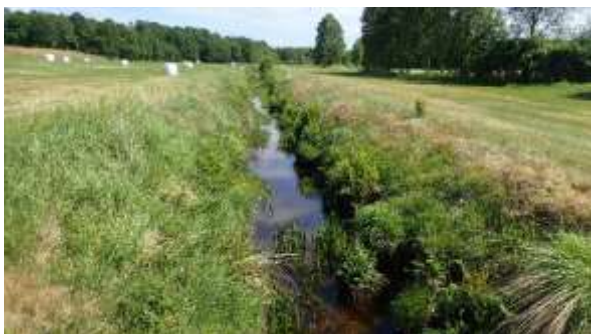
Sträckan är rätad och rensad, solljusinsläpp gör att vattendraget växer igen och medför att kravet på att rensa vattendraget ökar.
