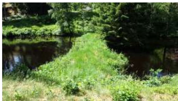
Damm 3. Längd 28 m och bredd 25 m samt mellan damm 3 och damm 4 (VH36). Plats för omlöp finns.
