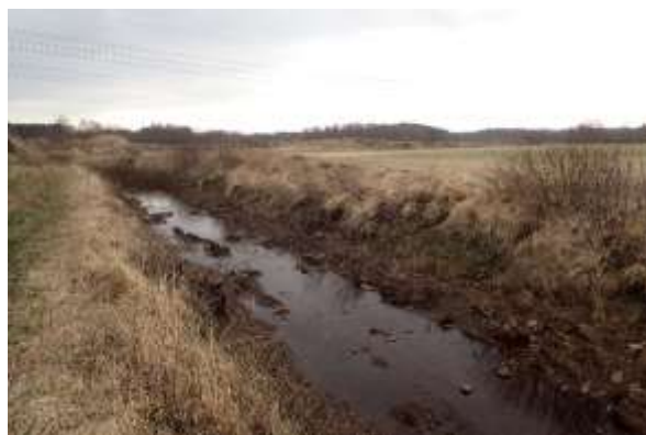
Sträckan är tidigare rensad och rätad och massorna finns på kanterna.
