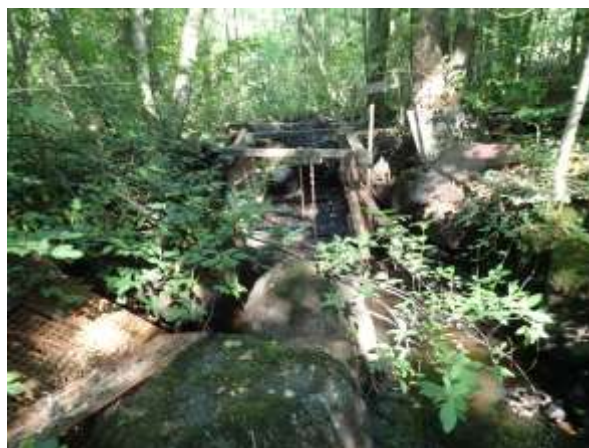
Förbättringar kan göras hela vägen och vandringshindret i form av gammal ålkista bör tas bort för att få öringens och laxens vandring till att fungera optimalt.
