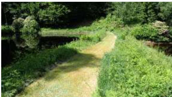
Damm 2. Längd 72 m och bredd 30 m. Mellan damm 1 (VH34) och damm 2. Här kan man göra omlöp.
